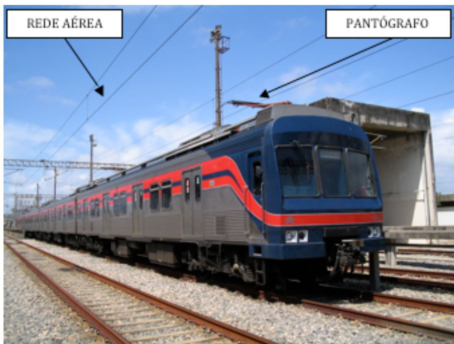
Figura 3-15. Rede aérea (CBTU/METROREC, 2009).
