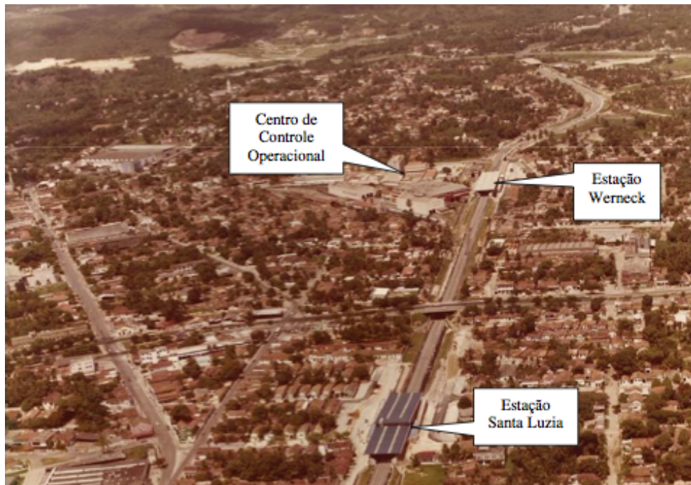
Figura 4-8. Vista Aérea entre estações Santa Luzia e Werneck (Araújo, 2009).
